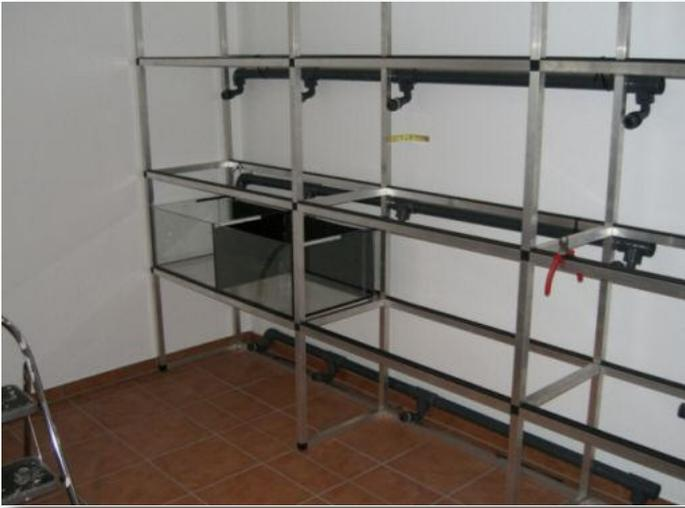
Nun können die Aquarien in das Regal gestellt werden und mittels Tankdurchführung an die Wasserleitung angeschlossen werden.
