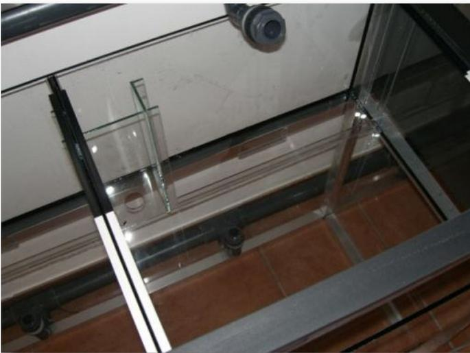
Alle Becken haben eine Bohrung (34 mm) in der hinteren linken Ecke für den Überlauf. Somit kann eine 25/32 mm Durchführung verwendet werden. Der Querschnitt des Ablaufs beträgt also 25 mm.
