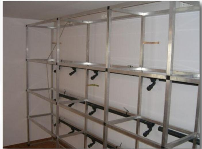
Hier wird die PVC-Wasserleitung der drei Ebenen schonmal in Position gebracht. Jedes Becken bekommt einen Überlauf und ist somit an die Wasserleitung angeschlossen. Diese kann später als Abwasserleitung oder als Sammelleitung zu einem Zentralfilter genutzt werden.
