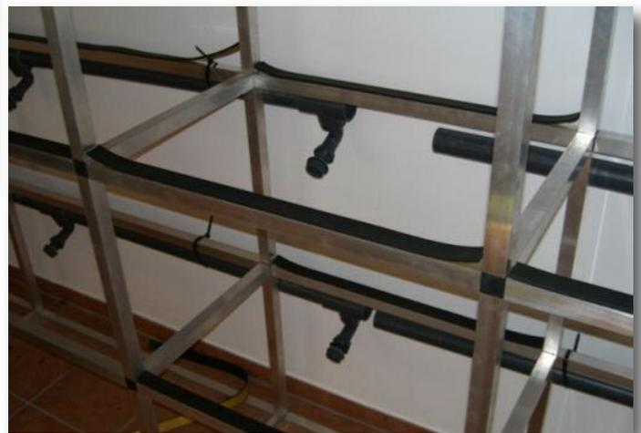
Auf die Alu-Profile kommt noch eine Bahn Moosgummi. Das erschien mir etwas sicherer, als das Glas einfach ohne Polster auf das Aluminium zu stellen.
