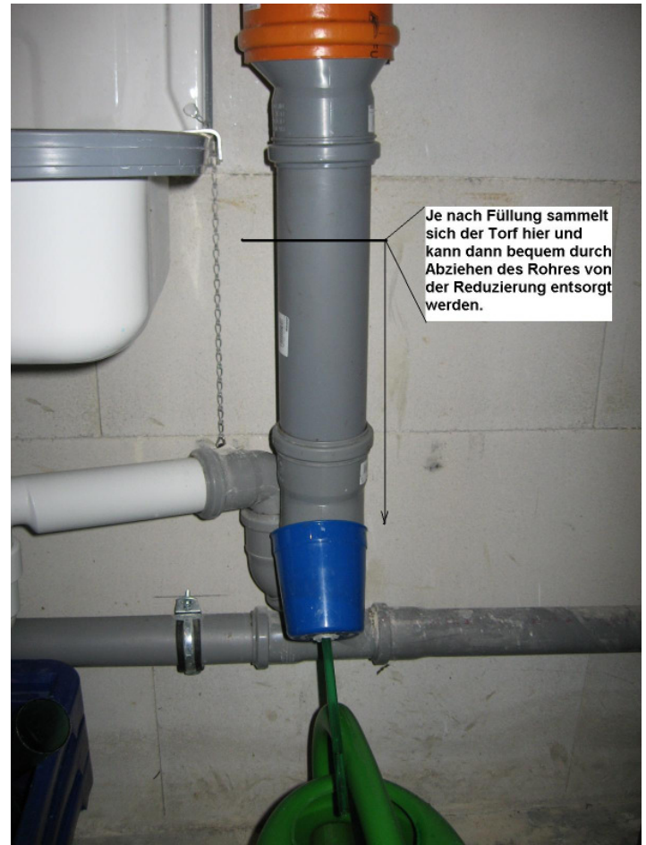
Bild 4: Entsorgung des Torfs
