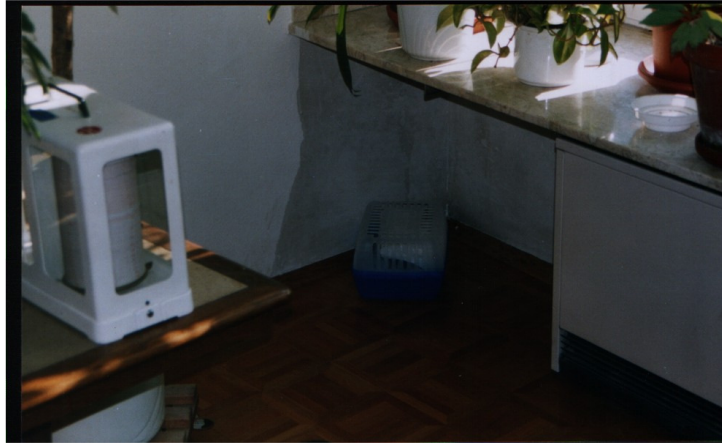
Schimmel in der Ecke, etwa 20 cm neben der Heizung und Wochenmessgerät.
